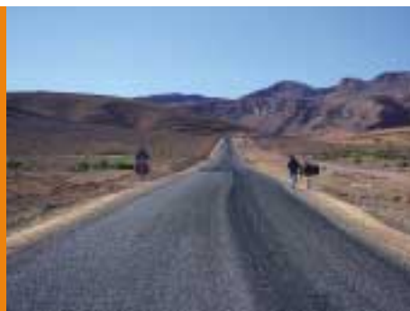
Les structures de Colas au Maroc réalisent près de 600 km de renforcement de routes par an.
