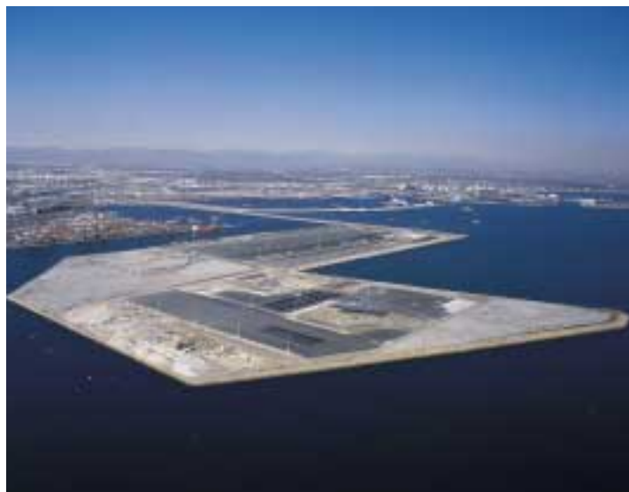
Sur le port de Los Angeles, construction d'une plate-forme de stockage de containers sur 97 hectares.
