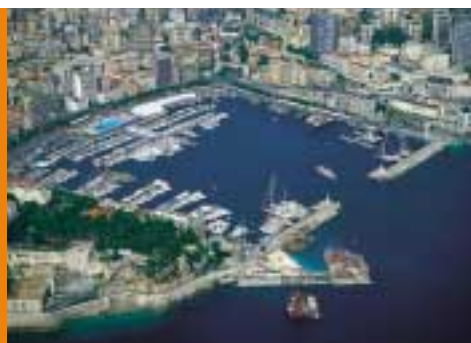
Les travaux d'extension du port de Monaco.
