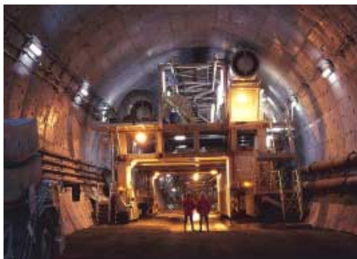
Le tunnelier de Groene Hart (Pays-Bas) est le plus grand du monde : 14,87 m. de diamètre.
