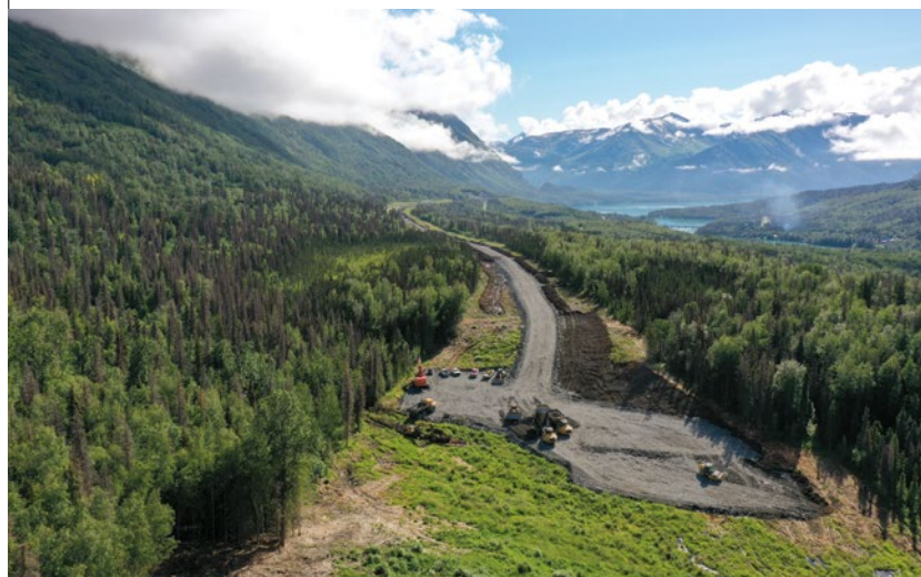
美国 - 在阿拉斯加南部的基奈(Kenai)半岛，Colas公司赢得一宗Sterling高速公路的重大改善工程：更新现有路面、建造超车道和生态管道，以及延长这条公路超过15公里。
