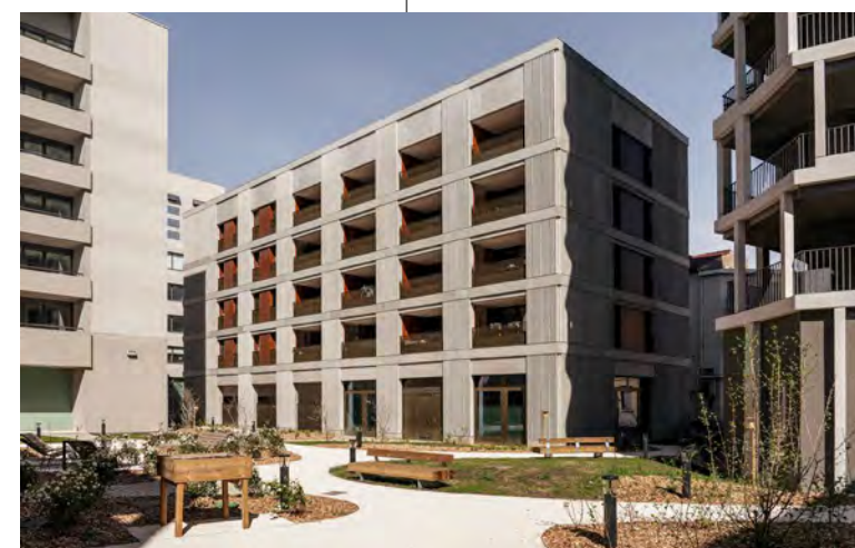
FRANCIA - En el corazón del barrio Lyon Confluence, Sollys es un proyecto mixto compuesto por oficinas, viviendas y comercios.
