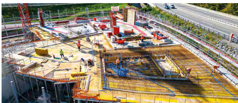
+ SUIZA - En el 131 Staufferstrasse en Berna, Losinger Marazzi (Bouygues Construction) diseñó y construyó un edificio de servicios con una estructura híbrida de madera.
