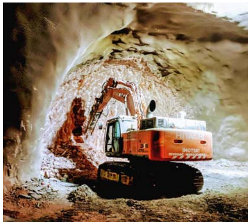
↓ Jumbo servant à réaliser le drilling pour l'excavation du tunnel d'Učka.
