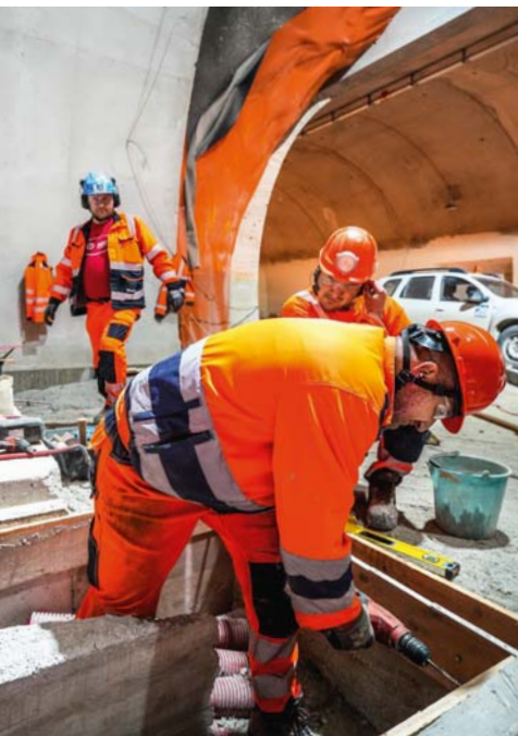
↓ Collaborateurs réalisant des travaux sur la chaussée.
