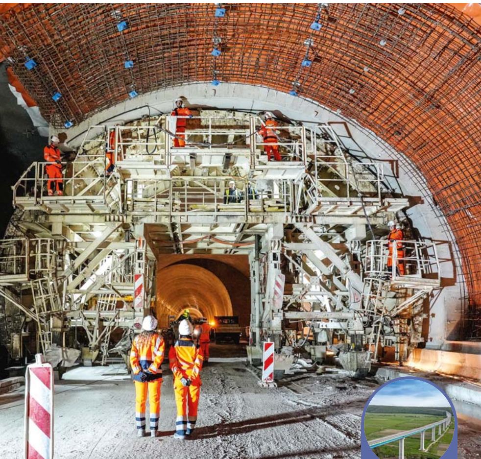
← Coffrage permettant de projeter le béton à l'intérieur du tunnel.
