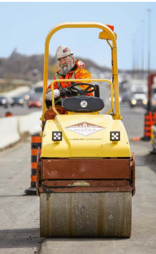
↓ Opération de compactage d'une couche d'enrobé sur l'autoroute 401.
